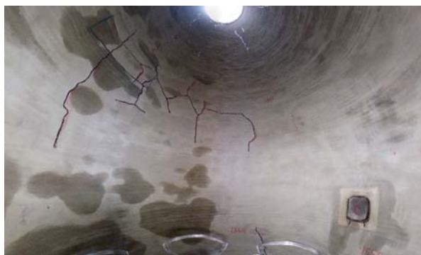
全天球カメラ撮影画像 (煙突内部)
